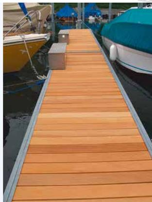
Sanierte Anlage mit neuen Schwimmkörpern, diese sorgen wieder für sicheren und lang anhaltenden Auftrieb. Der neue Belag rundet das Bild ab. Eine kostengünstige Alternative zur Neuanlage.
