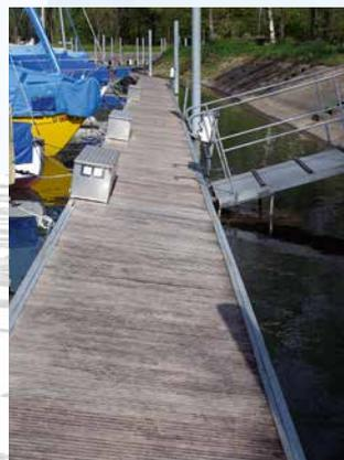
Alte Anlage, gefährlich schräg durch undichte Pontons und einer zu großen Belastung durch falsch entlastete Zugangsbrücken!
