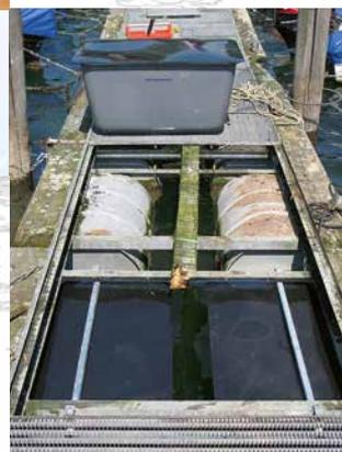
Vergleich alte Fässer und neue Lösung mit Standardpontons und Spezialhalterungen
